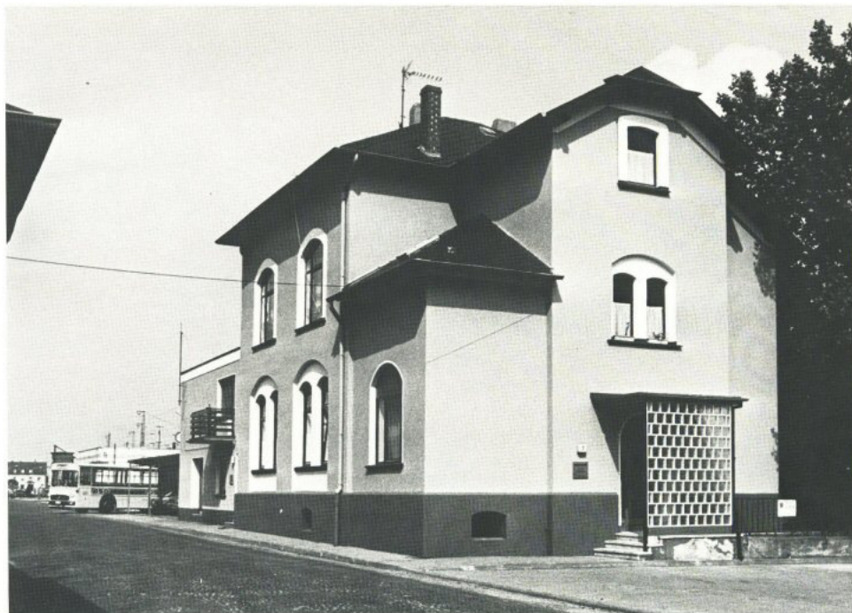
Das Verwaltungs- gebäude der Mosel- bahn-Gesellschaft in Trier, Schönbornstraße
