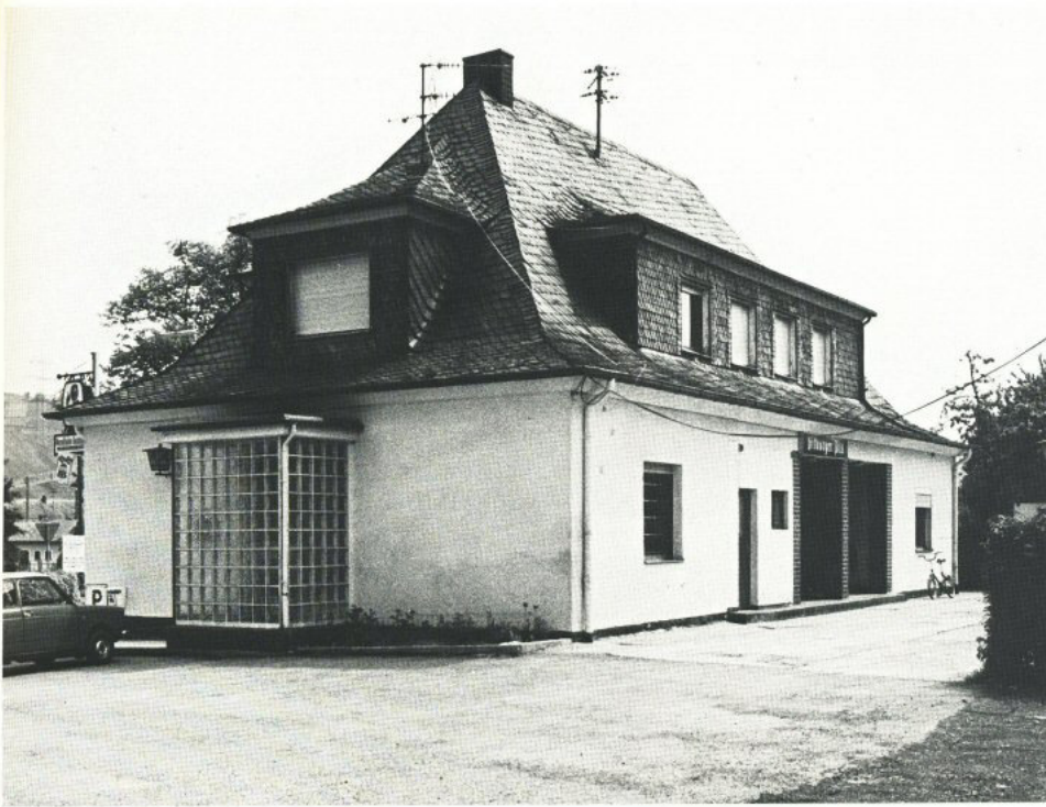
Behäbig und solide: das Bahnhofsgebäude von Longuich
